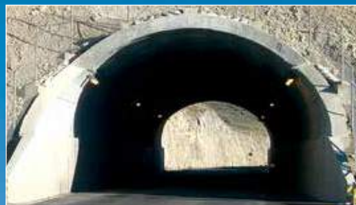
Túnel de Alcantarillas de Acero.
